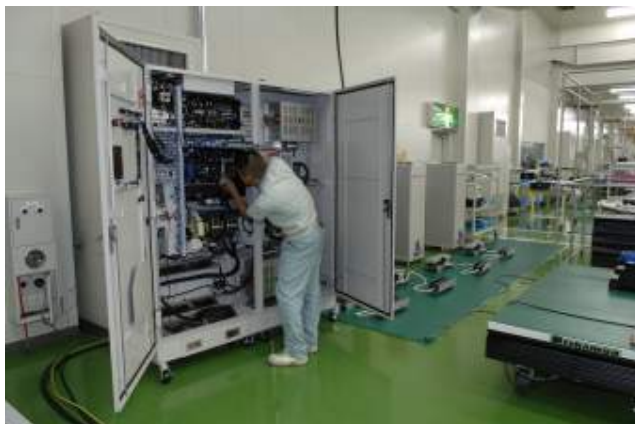
コンベヤ制御盤の制作風景
