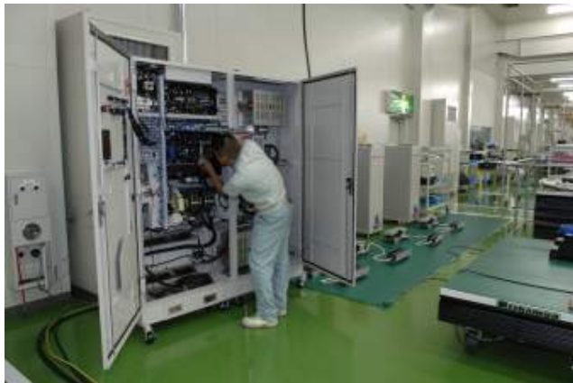
コンベヤ制御盤の制作風景
