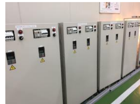
電力回生装置（PWMコンバータ）
