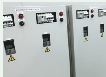
電力回生装置(PWMコンバータ)
