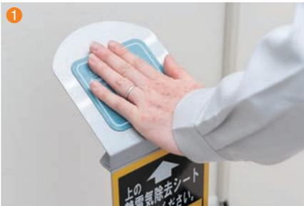
1 静電気除去シートにタッチし、帯電している静電気を放電
